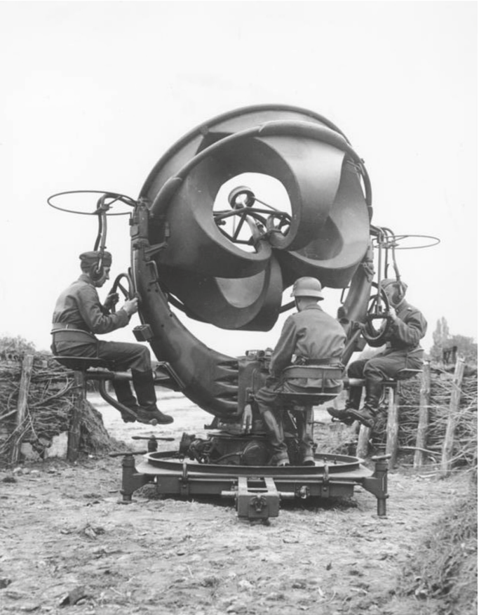
Abb. 1: Ringtrichter-Richtungshörer (RRH) zur Einweisung der schweren Flak. Bundesarchiv, Bild 183-E12007/Eisenhardt.
